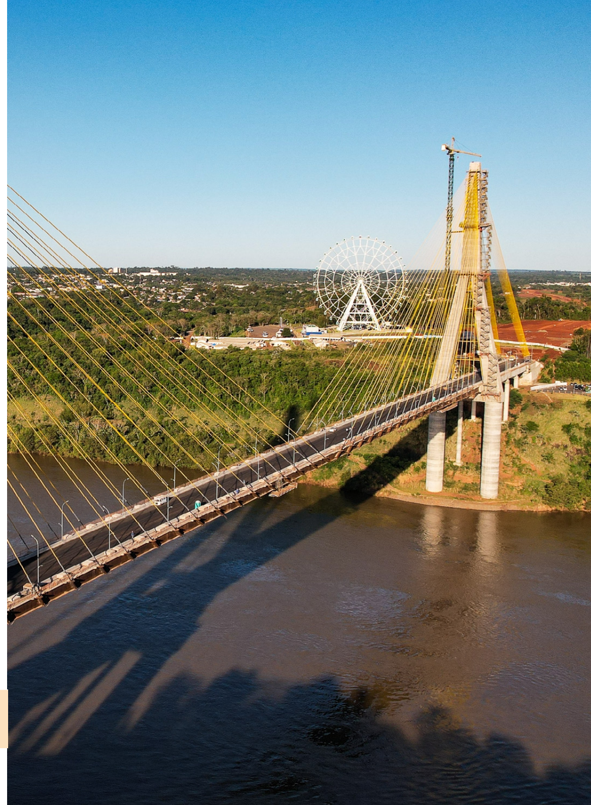
Fig. 27: Nova ponte, quando ainda estava em construção, sobre o Rio Paraná.
