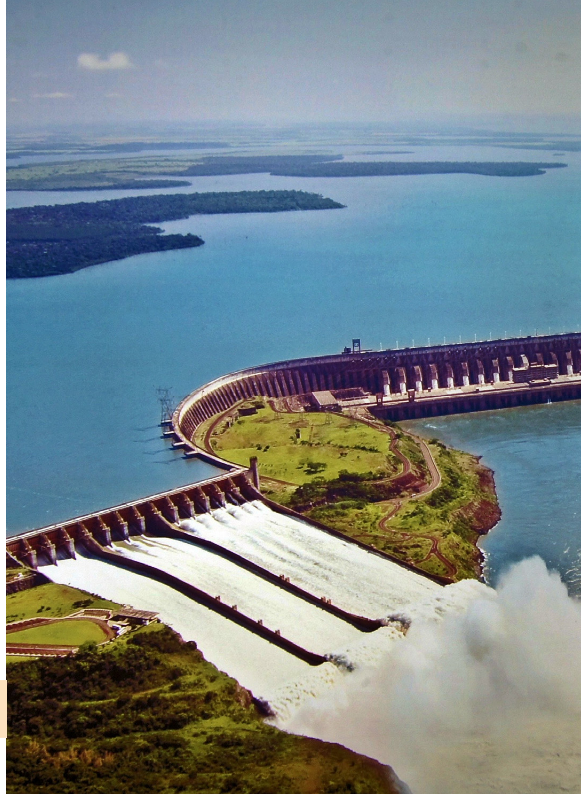
Fig. 25: Vertedouro da usina hidrelétrica de Itaipu. Fig. 25: Vertedero de la central hidroeléctrica de Itaipu. Foto: Jonas de Carvalho. Creative Commons Attribution-ShareAlike 2.0
